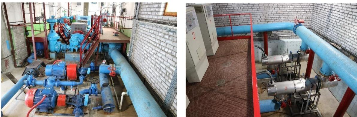
**Рисунок 2 - Насосная станция 2-ого подъема с установками УФ- обеззараживания.**
