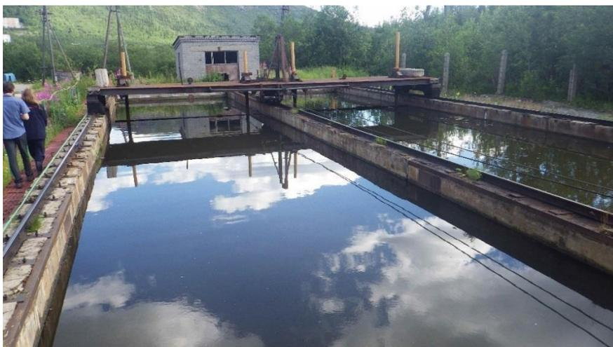
**Рисунок 24 - Вторичный отстойник КОС №2.**
