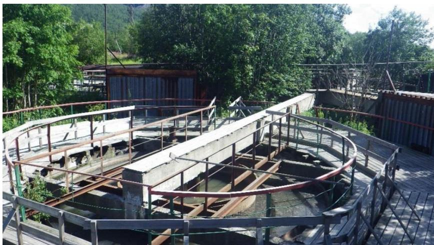
**Рисунок 22 - Осветлитель-перегниватель КОС №2.**
