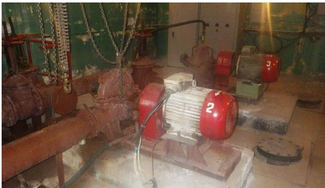
**Рисунок 10 - Насосное оборудование НС-3 для подачи воды в квартал 3/8.**
