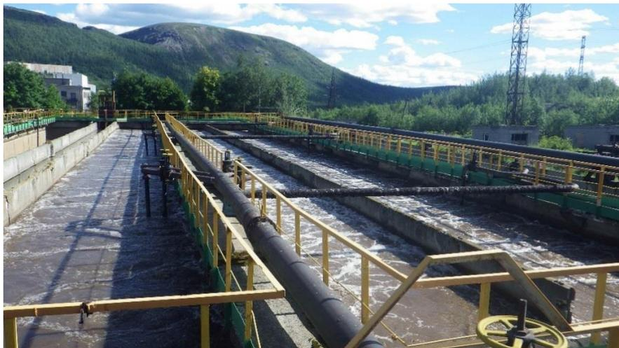
5. Вторичные отстойники горизонтального типа – 6 ед. (рисунок 24). Для выделения из сточной воды нерастворимых примесей, которые остаются после очистки на аэротенках, применяются вторичные отстойники. Общий рабочий объем - 2440 м<sup>3</sup>, время пребывания сточных вод во вторичных отстойниках - 1.18 часа. Процент износа составляет 44%.
