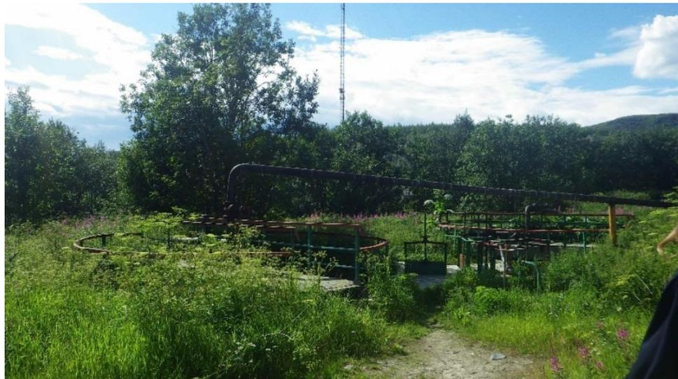
3. Осветлители-перегниватели – 8 ед. (рисунок 22). Осветлители-перегниватели предназначены для отделения более легких частиц и всплывающих загрязнений, после чего сточные воды поступают на биологическую очистку. Объем осветлителей - 1680 м<sup>3</sup>, время отстаивания – 0,82 часа. Процент износа составляет 44%.
