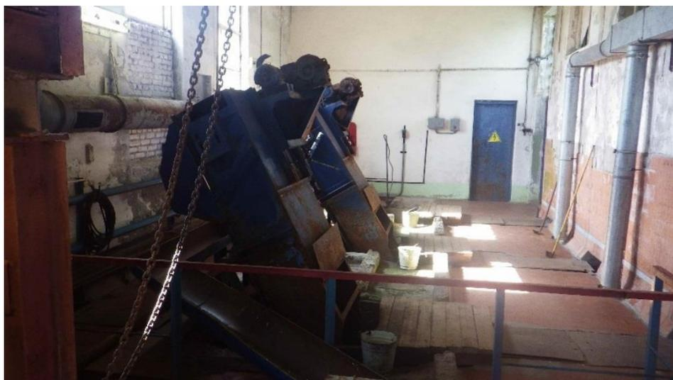
2. Горизонтальные песколовки с круговым движением воды диаметром 6 м – 2 ед. (рисунок 21). Песколовки предназначены для задержания
