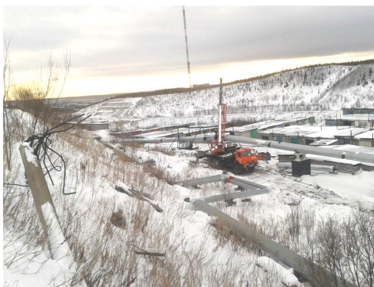
Рисунок 1.3.1 Строительство тепломагистрали между ТНС-3а и ПНС.
