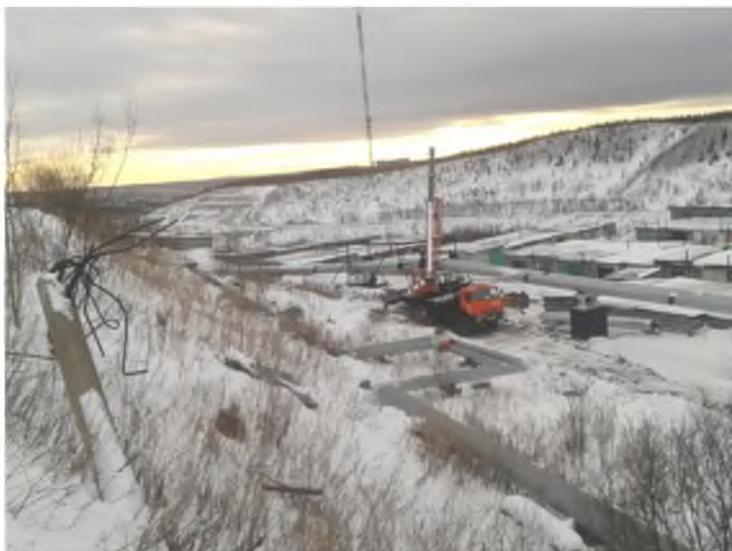
Рисунок 1.3 Строительство тепломагистрали между ТНС-3а и ПНС.
