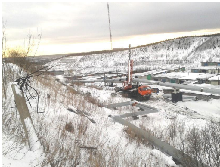
Рисунок 1.3.1 Строительство тепломагистрали между ТНС-3а и ПНС.
