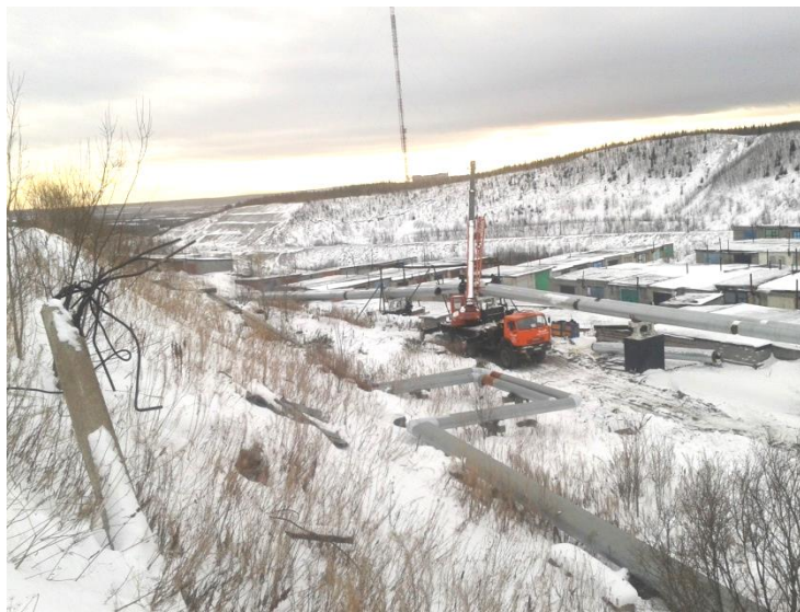
Рисунок 1.2.1 Строительство тепломагистрали между ТНС-3а и ПНС.
