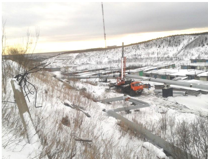
Рисунок 1.2.1 Строительство тепломагистрали между ТНС-3а и ПНС.
