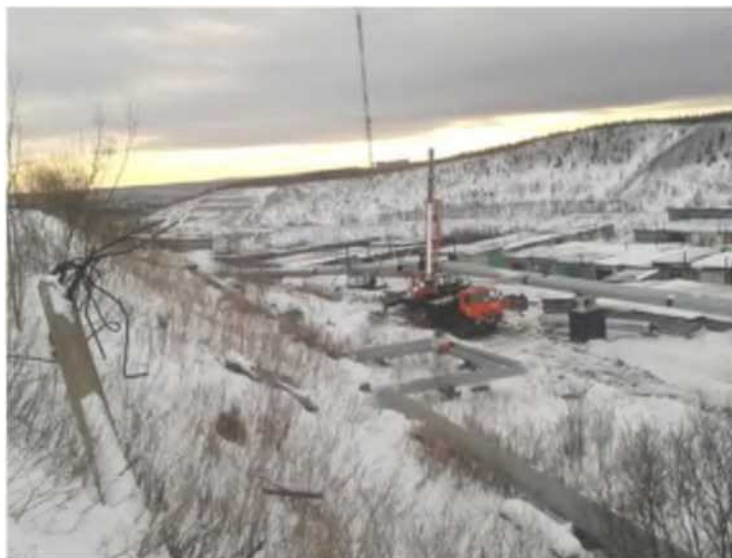
Рисунок 1.3 Строительство тепломагистрали между ТНС-За и ПНС.
