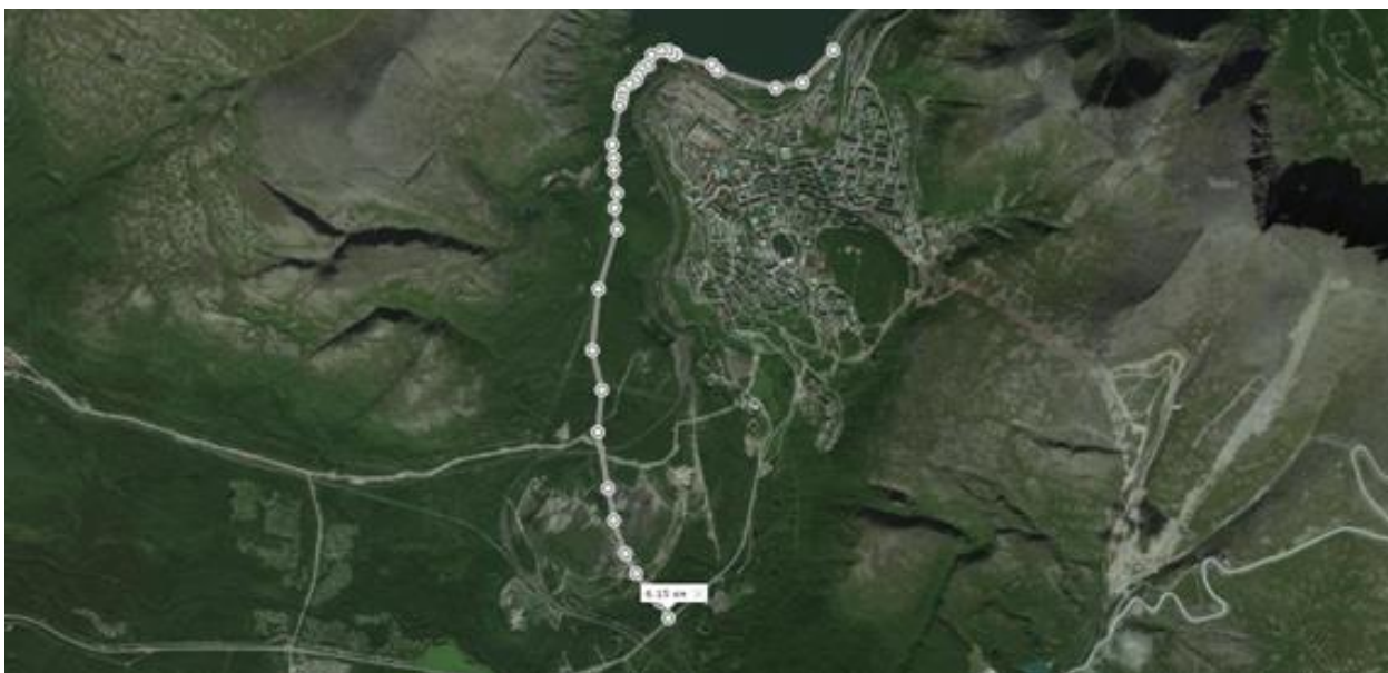
Рис.17 – Вид со спутника объездной дороги и искусственных сооружений на нем (инвестиционный проект)
